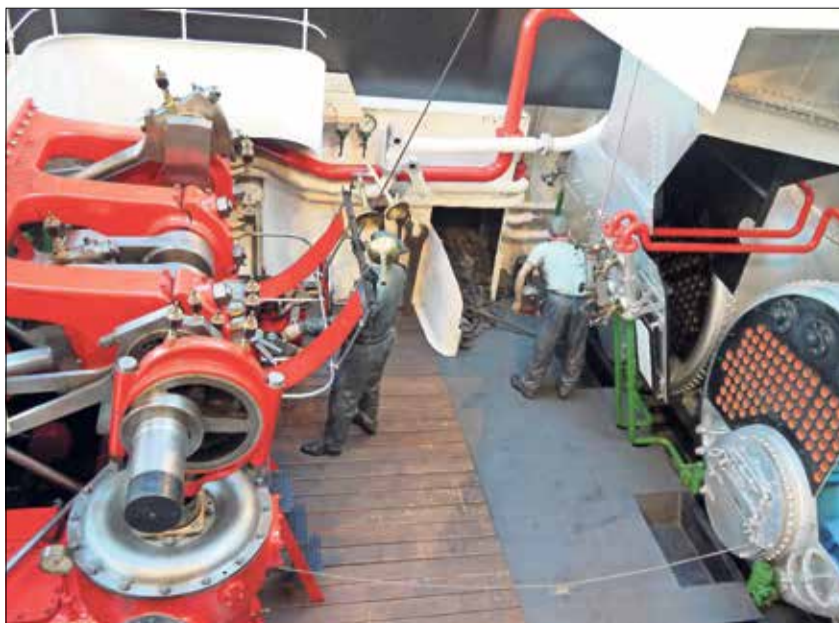
Teile des im Verkehrshaus ausgestellten Maschinenraums von DS Pilatus lassen erahnen, wie hart die Arbeit zur Zeit der Kohlenfeuerung gewesen ist.
